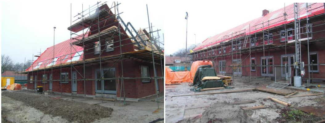
De bouw van de woningen aan Het Boerenerf vordert gestaag.
