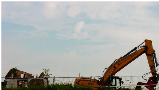
De bouwval aan de Veerweg wordt opgeruimd
