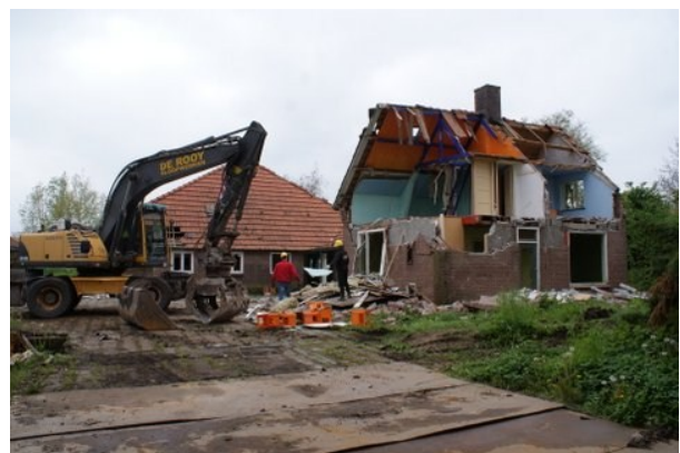
De sloop, hier nog in volle gang, is inmiddels voltooid.
